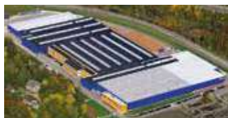
Hörmann KG Eckelhausen, Allemagne
