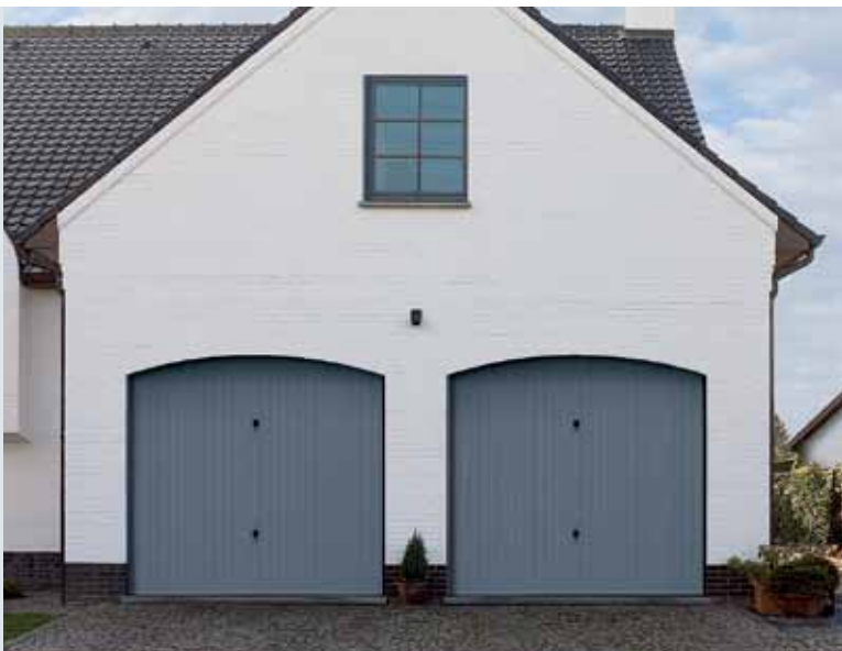
L'ouverture totale du garage est fermée par le tablier de porte.
