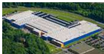
Hörmann KG Eckelhausen, Allemagne
