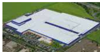
Hörmann KG Ichttershausen, Allemagne
